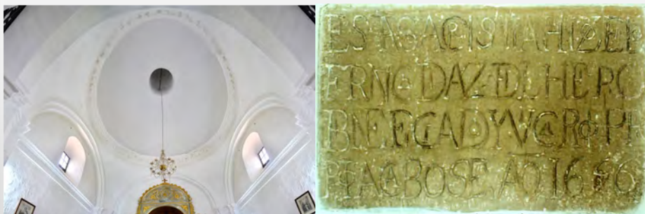
Cúpula de la cabecera y placa de terminación de la sacristía (1686)
