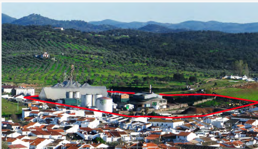
Vista general de la fábrica de aceites
