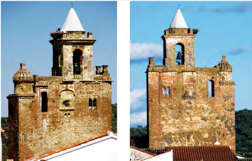
Fachadas de la torre: este y oeste
