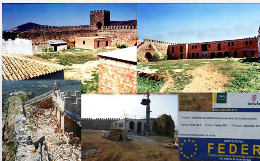
Vistas de las obras realizadas y de su demolición.
