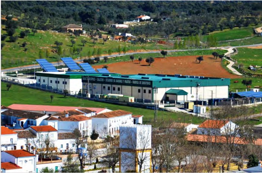
Vista general del secadero de jamones y sala de despiece
