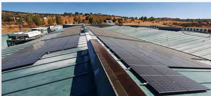
Paneles solares fijos en toda la cubierta del secadero (instalándose)
