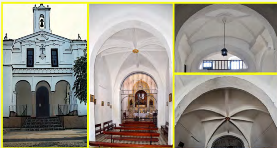
Imafronte, vista interior, bóveda del primer tramo, bóveda segundo tramo
